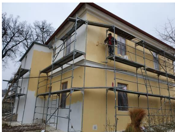
Oprava fary - nátěr fasádní barvy
